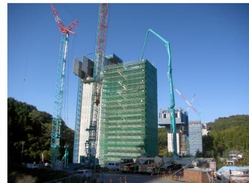
⑥橋脚部コンクリート打設
