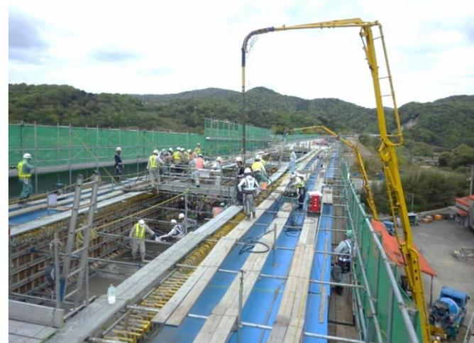
④上部工コンクリート打設
