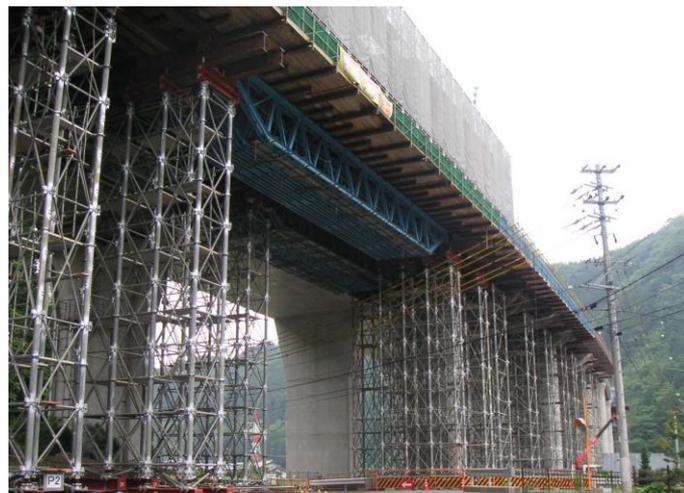
①支柱式支保工、②仮設梁設置
