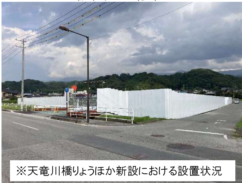
仮囲いの設置
