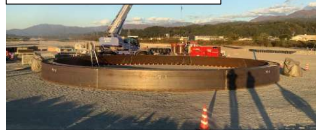
①作業室構築
