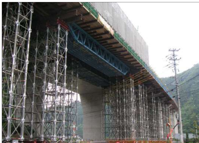
①支柱式支保工、②仮設梁設置
