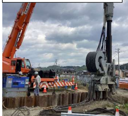
①鋼矢板打込み
