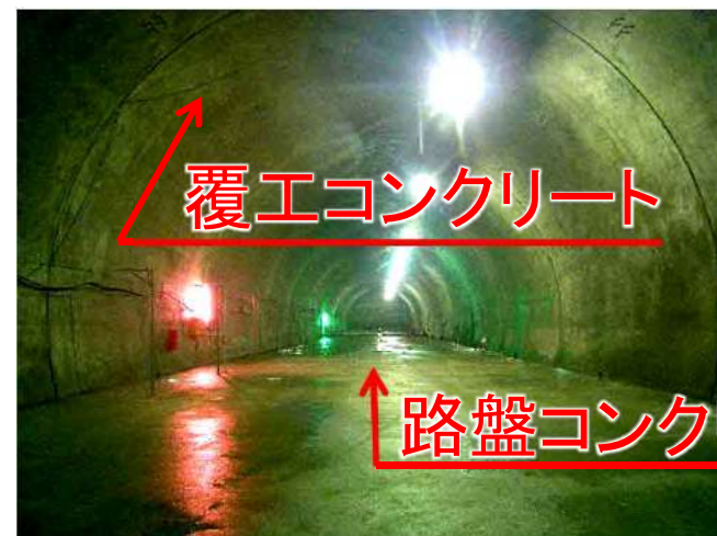
⑥覆工・路盤コンクリート
