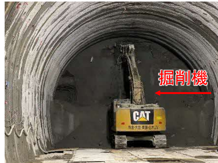
①機械掘削
