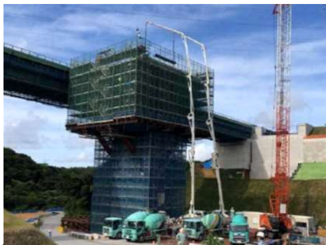
①柱頭部構築
