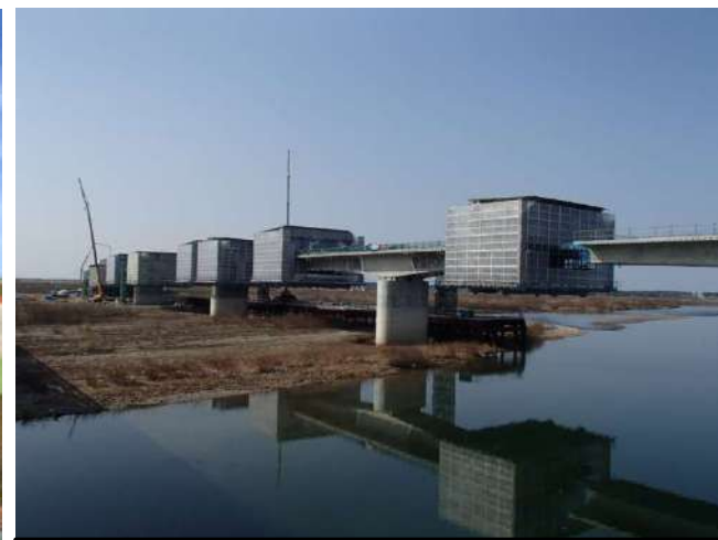
③張出し架設
