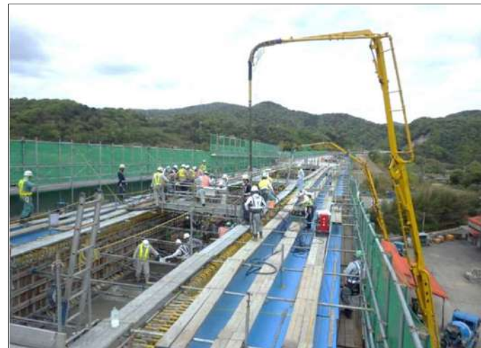
④上部工コンクリート打設
