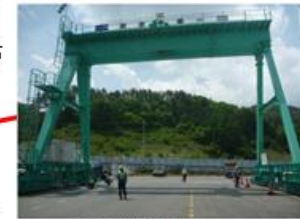
運搬クレーン
