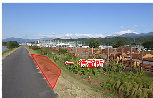
写真1 (待避所の設置箇所)
