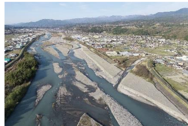
写真-瀬替え完了状況
