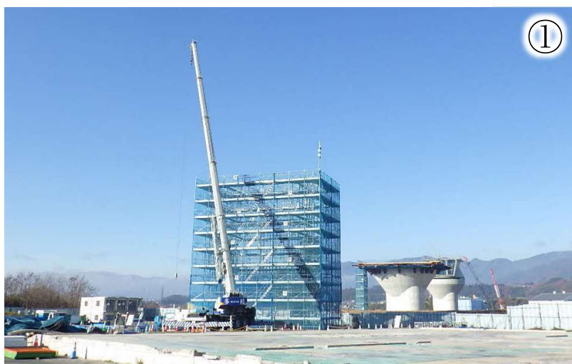
橋脚工事の様子
