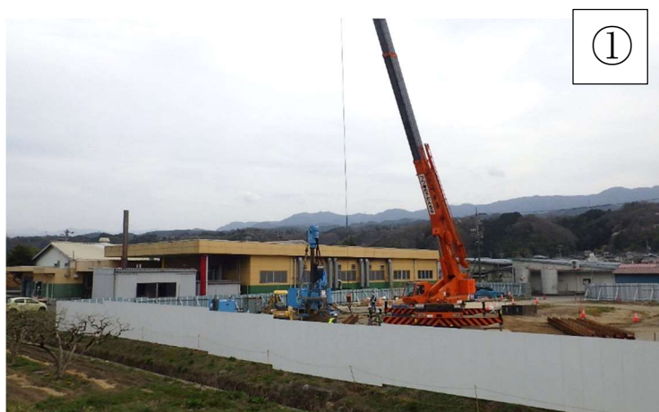
基礎工事の様子
