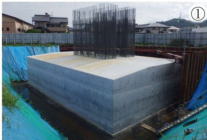
高架橋の基礎
