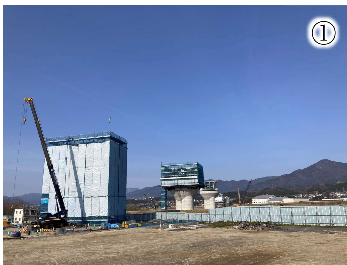
橋脚工事の様子
