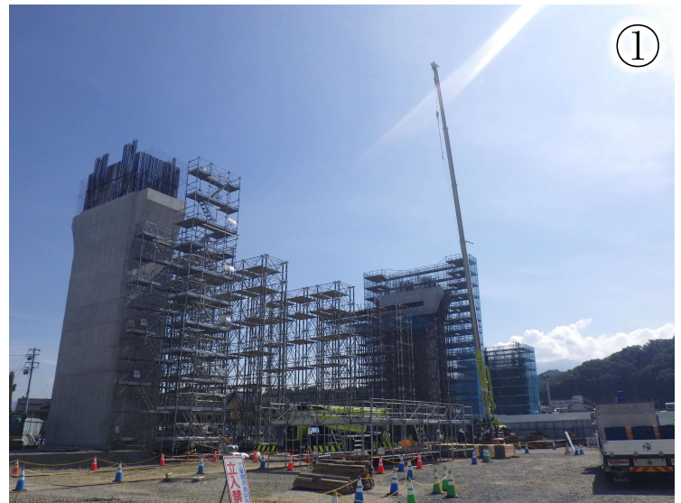
竜東一貫道路の東側ヤード
