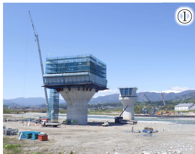
天竜川橋りょうP2の様子
