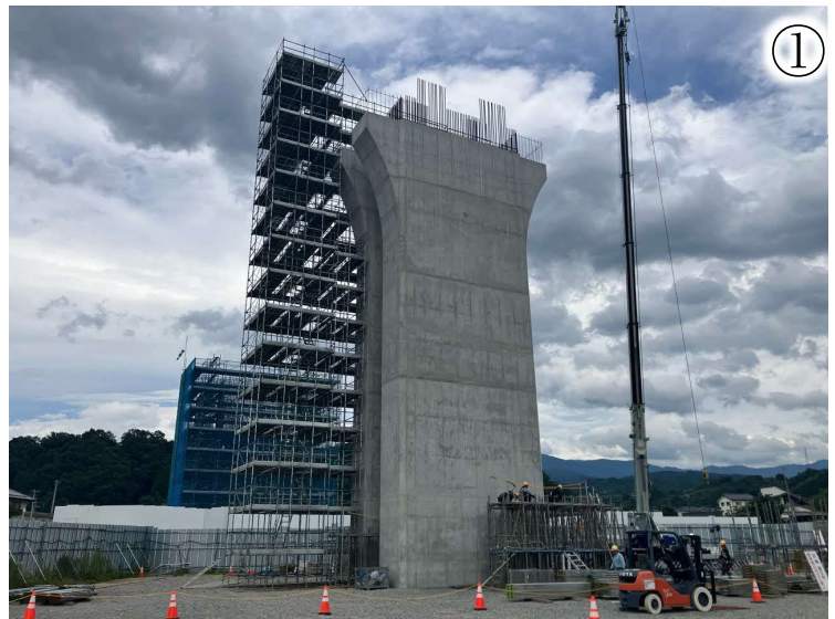
竜東一貫道路の東側ヤード
