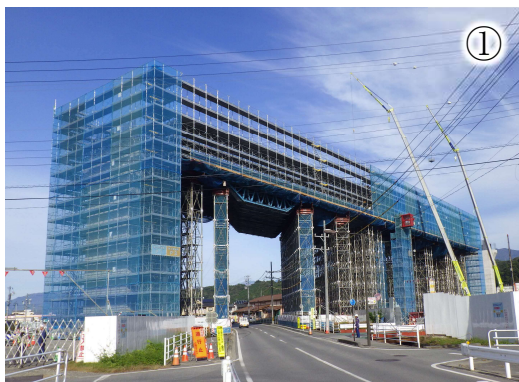
上部工工事の施工状況
