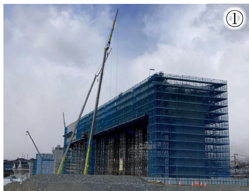
上部工工事の施工状況
