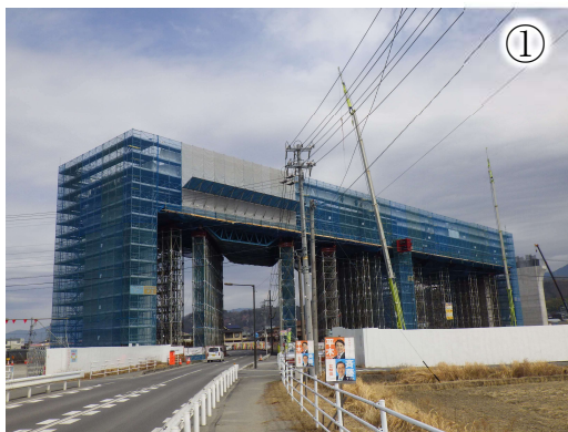
上部工工事の施工状況
