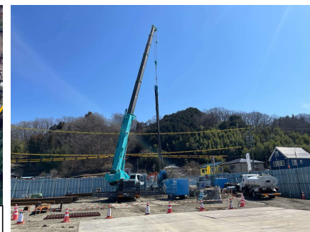
鋼矢板圧入状況
