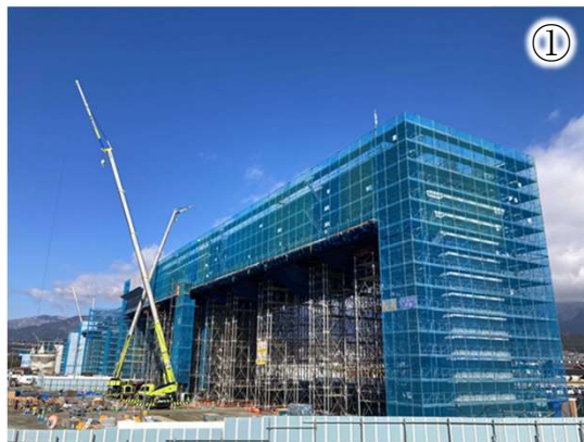
上部工工事の施工状況
