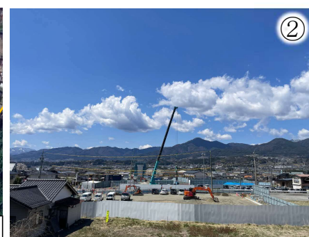
工事の施工状況
