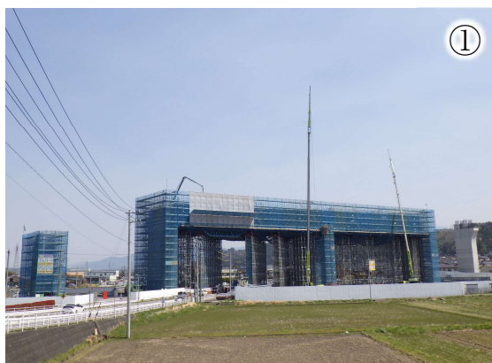
上部工工事の施工状況
