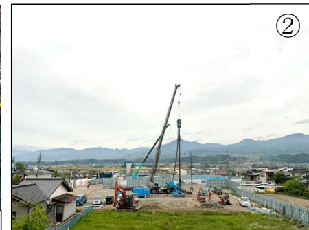
工事の施工状況
