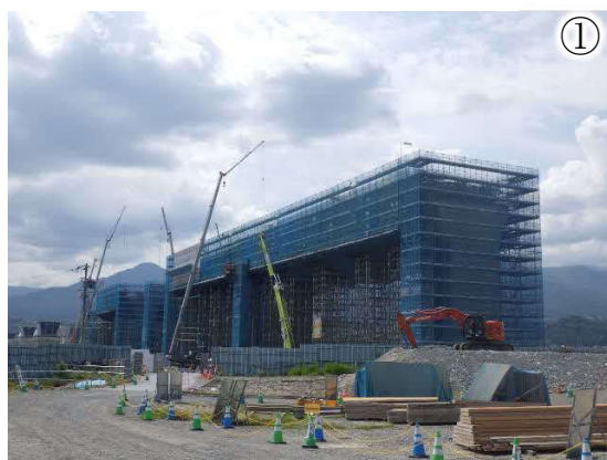
上部工工事の施工状況
