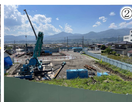
工事の施工状況
