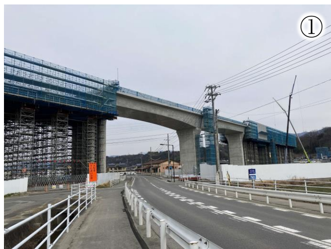
上部工工事の施工状況
