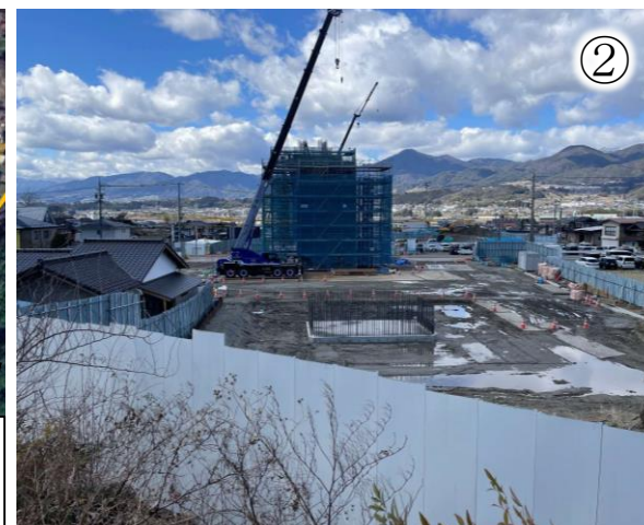
工事の施工状況
