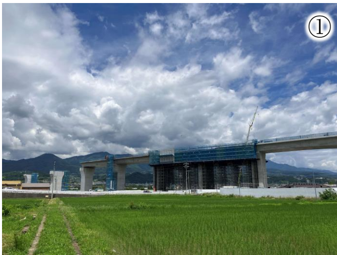
上部工工事の施工状況
