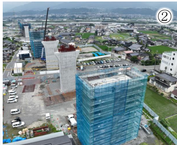
工事の施工状況
