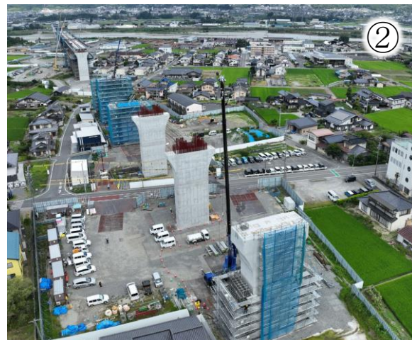
工事の施工状況
