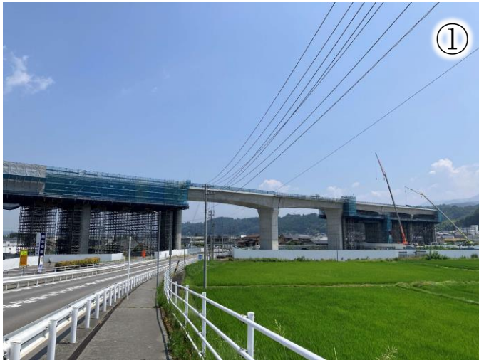
上部工工事の施工状況
