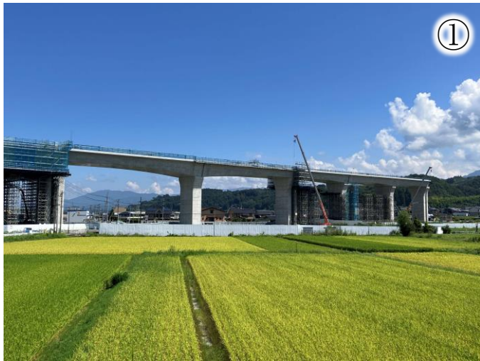
上部工工事の施工状況
