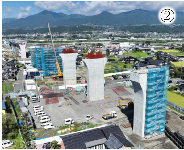
工事の施工状況
