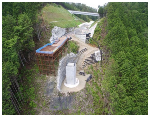
P1橋脚（施工後）
