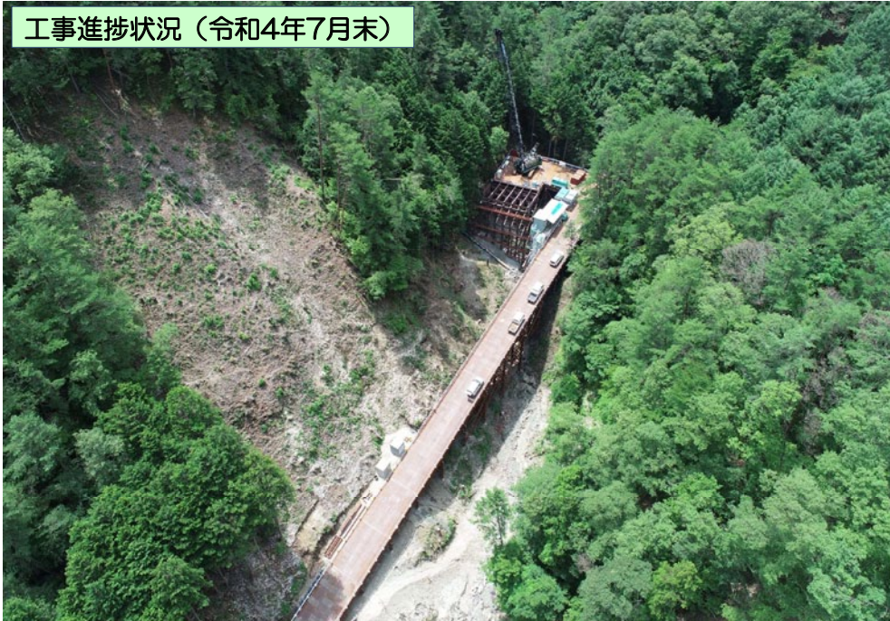
仮橋工事状況
