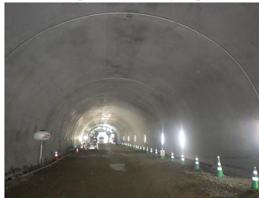
【トンネル坑内状況】
