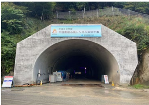
小嵐トンネル坑口
