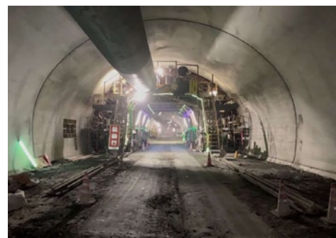
覆工施工状況 (1870m地点)
