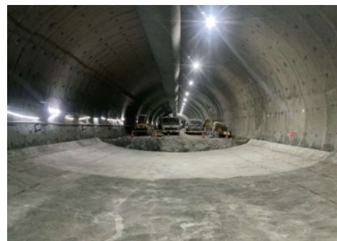
インバート施工状況 (2540m地点)
