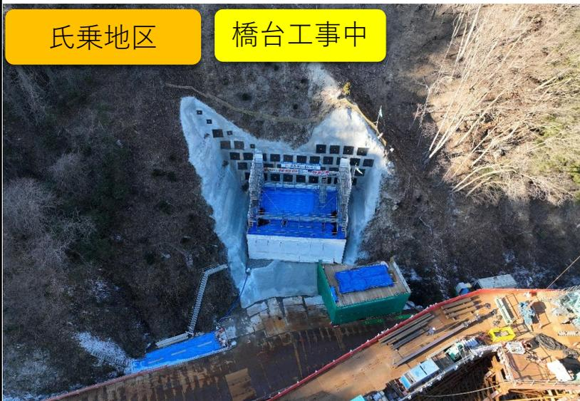
氏乗地区は深礎工が完了し、現在橋台フーチング部の鉄筋工とコンクリート打設作業が進んでいます。
