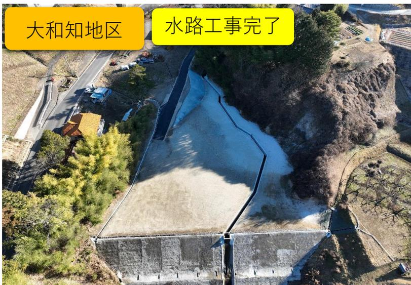
大和知地区は水路工が完了し、接続道路の舗装とその法面へのモルタル吹付作業を施工して作業が完了しました。
