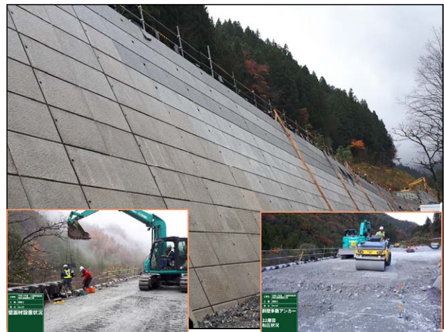
壁面材据付状況
