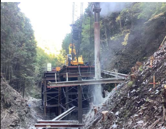
【橋脚杭削孔作業状況】
