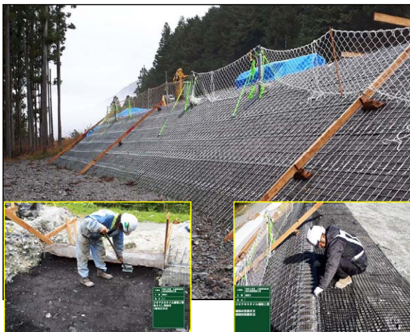
盛土材突固め状況
