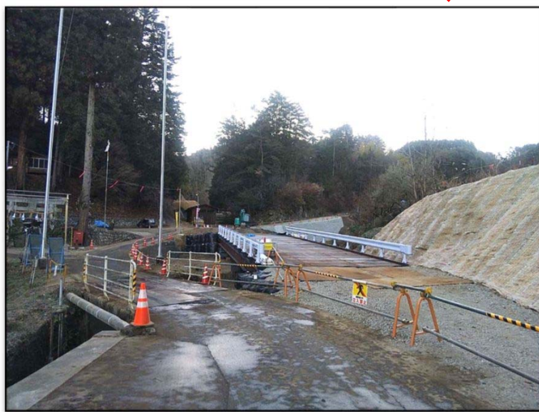
△ 富田諏訪神社前 1号仮橋完成 (1月25日現在)
