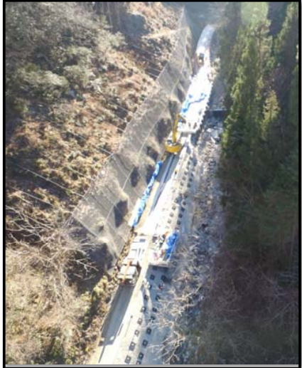
現場中心部から終点を望む
