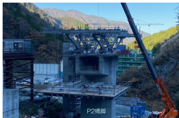
移動作業車 組立状況
