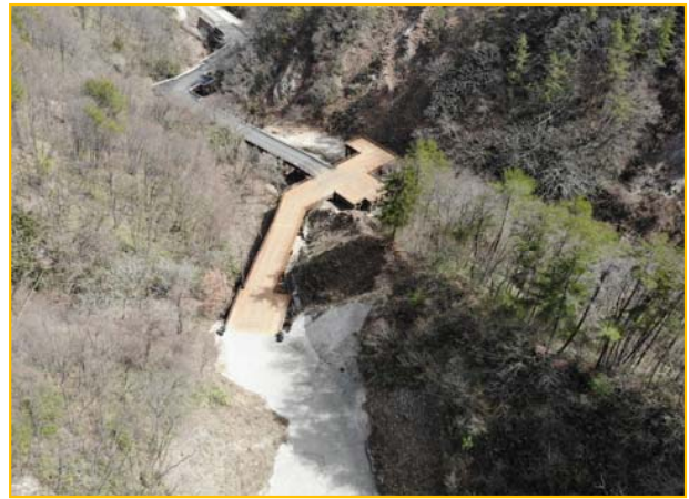
雨沢工事用道路
