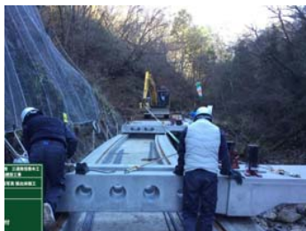
張出床版施工状況
