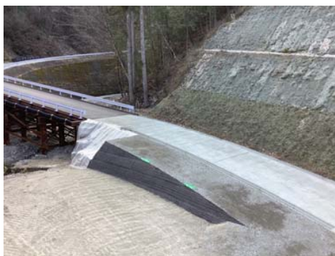
補強土壁工・法面防護マット
