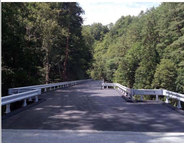
工事用道路舗装
