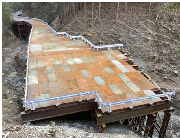
3号仮橋延伸部
