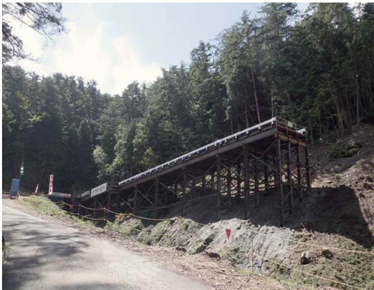
△ NO.70付近 2号仮橋完成 (9月24日現在)
