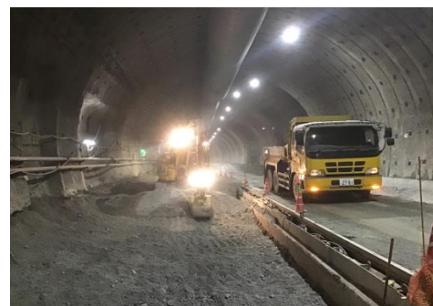
インバート施工状況 (1420m地点)
