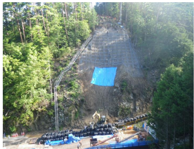
P2 作業状況
