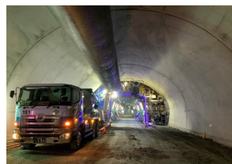
覆工施工状況 (860m地点)
