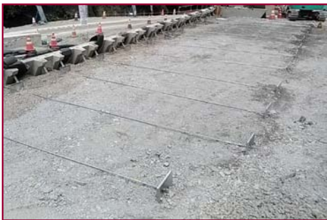
アンカー鋼材設置
