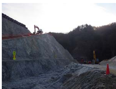
掘削部進捗状況
