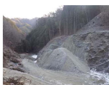
8号函渠進捗状況
