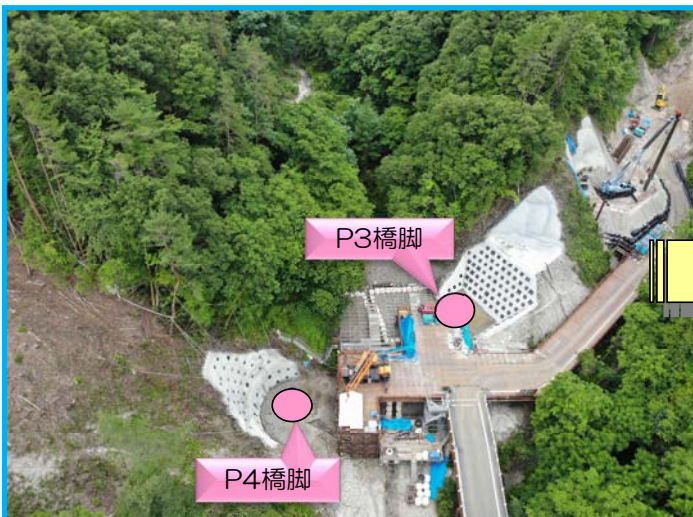
令和3年7月末 施工状況写真
