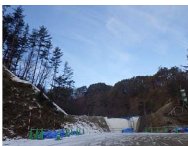
橋台工(A2)進捗状況
