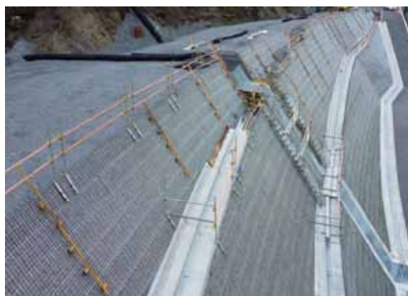
【ジオテキスタイル補強土壁】
