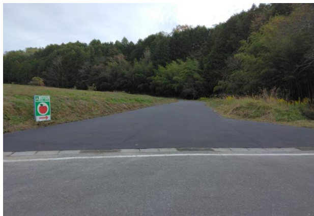
原平工事用道路 11月完成
