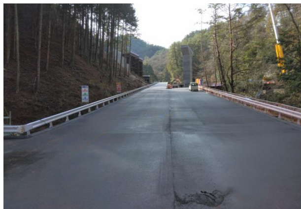
小豆沢工事用道路 1月完成
