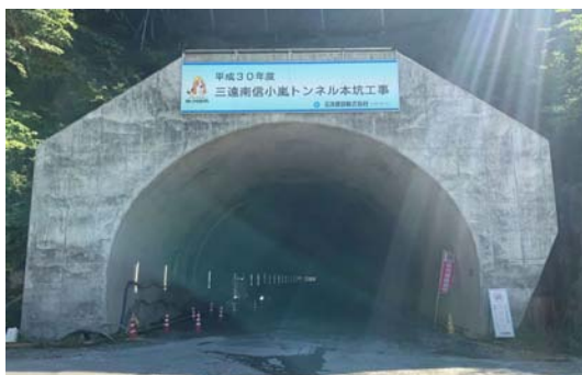
トンネル坑口状況
