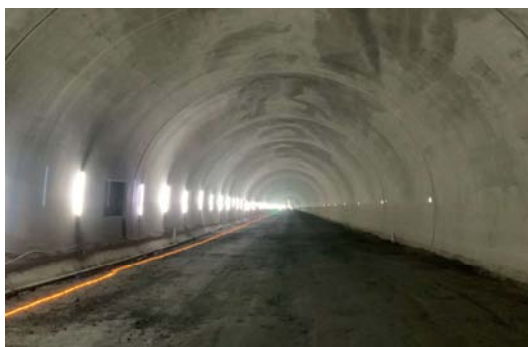
本坑部覆工状況
