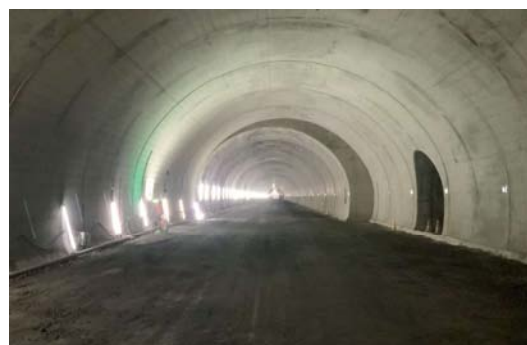
非常駐車帯部覆工状況
