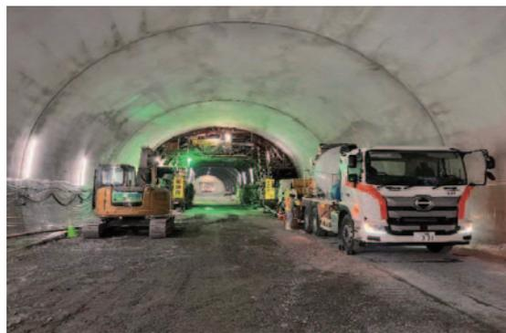
覆工コンクリート打設状況
