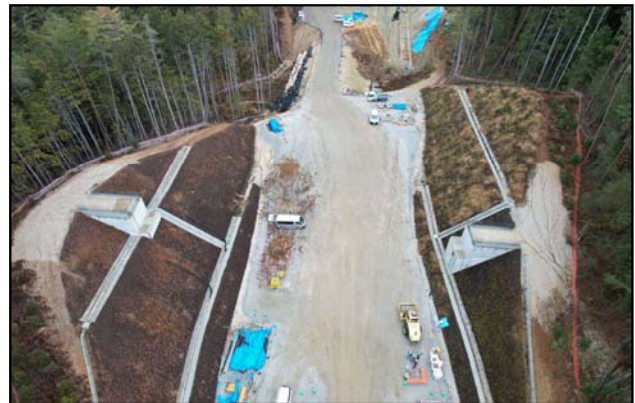
【富田地区_4号跨道橋】
