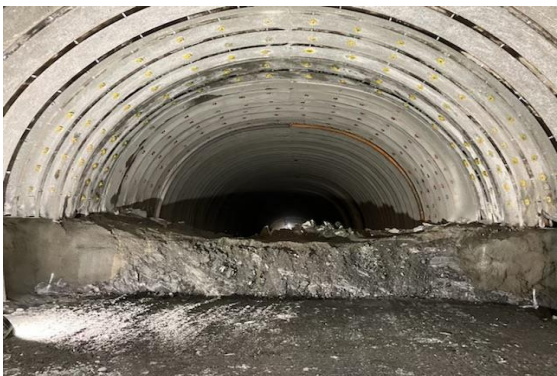
貫通点(掘削施工時)
