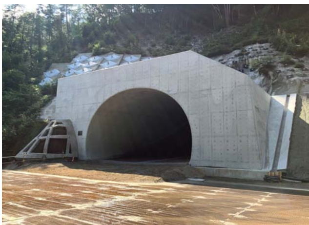
起点(氏乗)側坑口完成写真
