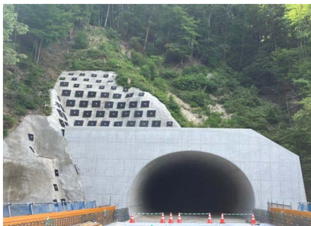
終点(矢筈)側坑口完成写真
