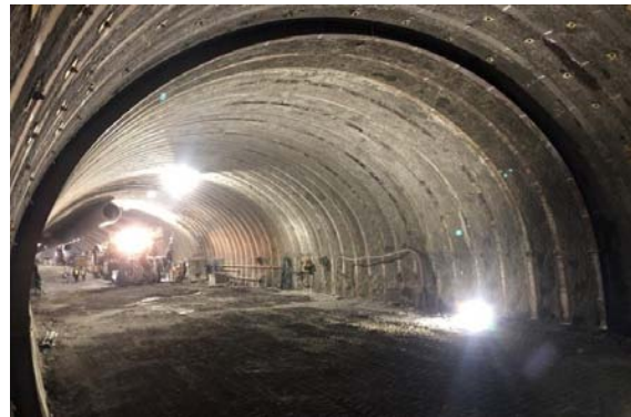
二重支保工施工状況
