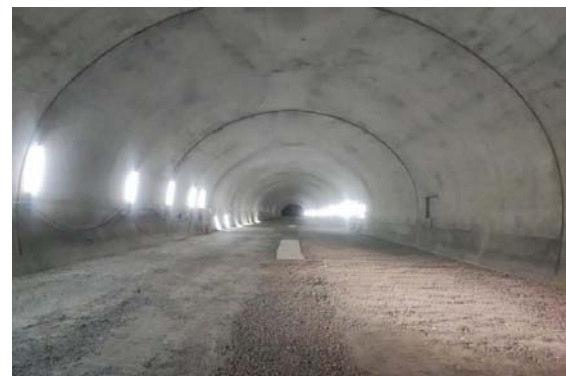
貫通点(覆工完了後)
