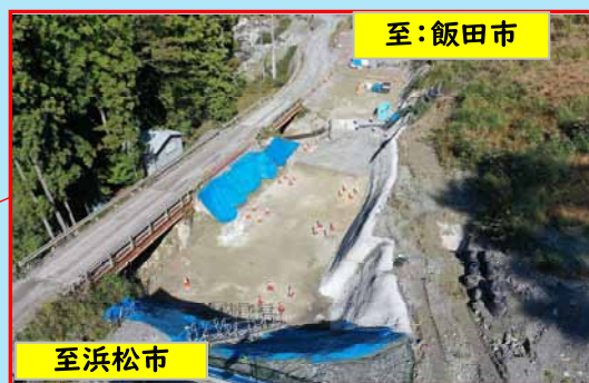
地盤改良状況（薬液注入工）
