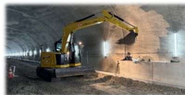
【情報ボックス工 施工状況】
