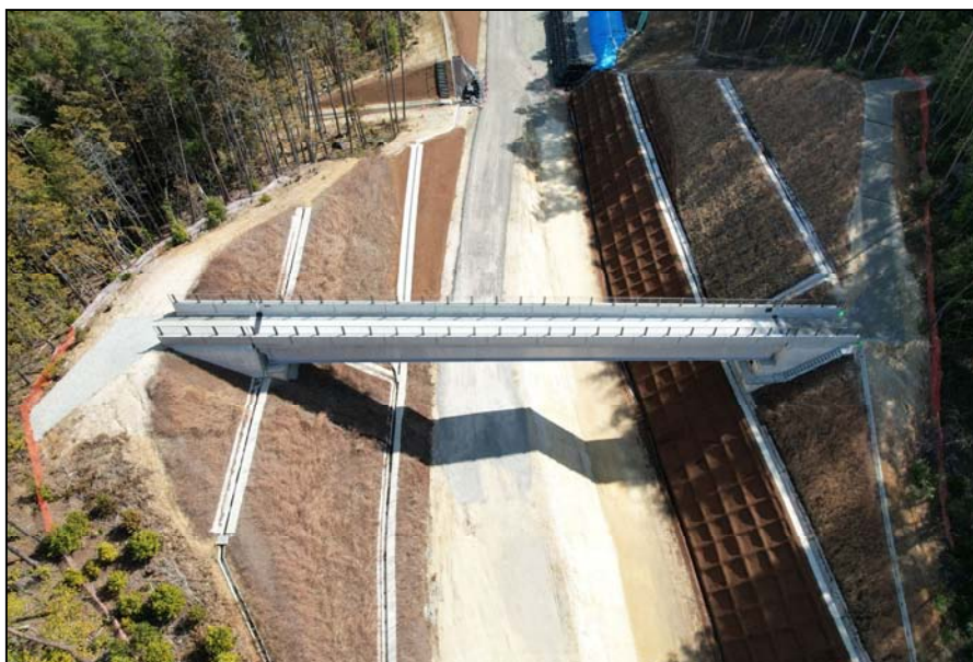
富田地区 4号跨道橋
