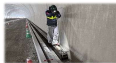
【情報ボックス工 施工状況】
