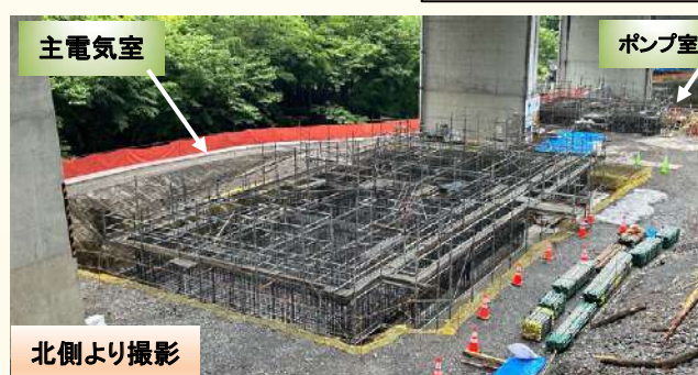
現在の施工状況写真
