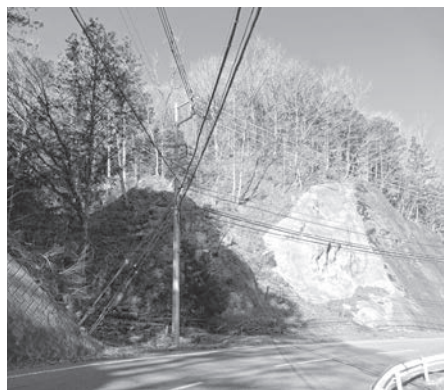
小川(村道6号線 九十九谷)
