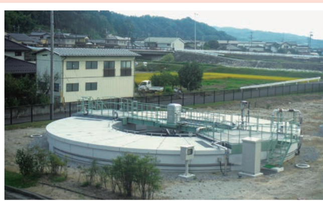
◆堰下浄化センター3池目処理槽の工事が完了しました 堰下処理区と伊久間処理区の下水処理区域を統合し、処理経費の削減を図ることを目的として建設を進めていた3池目となる汚水処理槽の建設工事が完了しました。また、伊久間地区からの下水道管布設工事もしゅん工し、処理区域の統合が完了しました。
