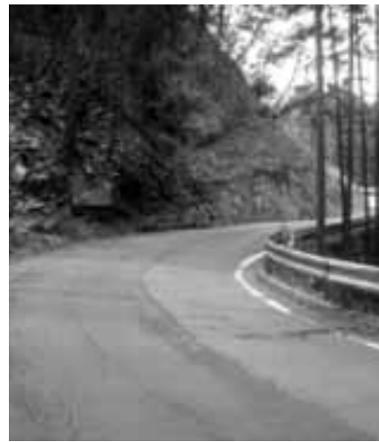
改良工事に着手する村道7号線 (大和知~氏乗)
