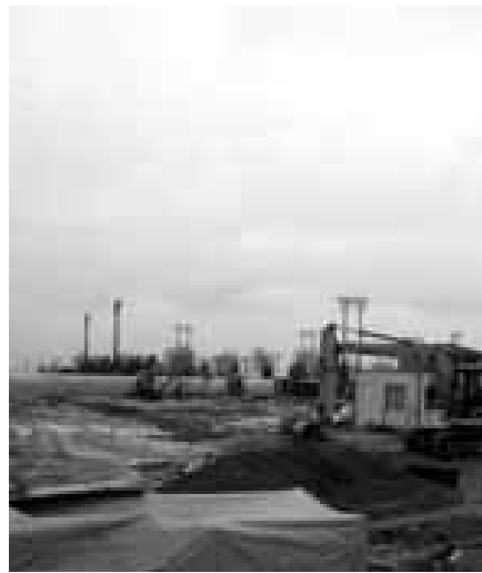
造成工事が進む中原住宅団地
