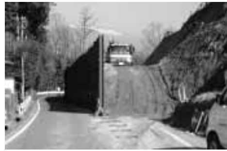
工事が本格化する村道七号線
