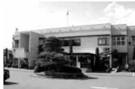
耐震改修を行う役場庁舎
