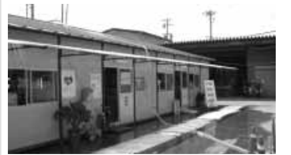
役場仮庁舎では冷房用に屋根上散水が行なわれています
