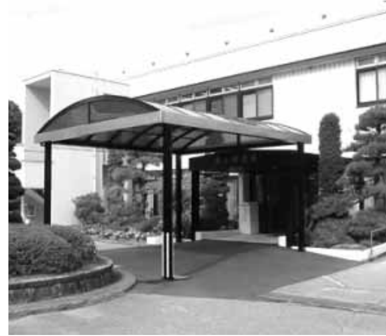
正面玄関車寄に大きな庇を設置しました
