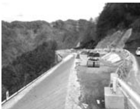
改良工事が進む村道7号線 (大和知)
