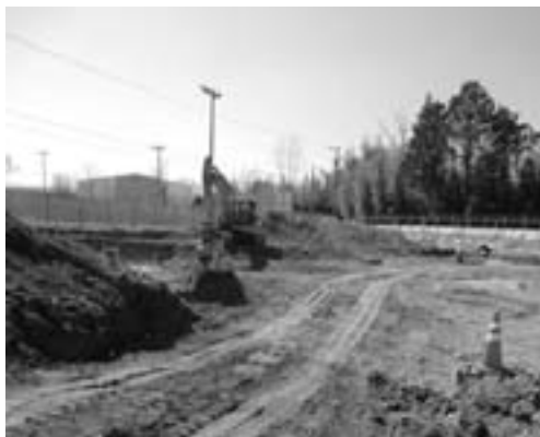
工事が進む調理場建設現場
