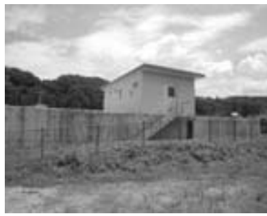
的場配水池 (小川・上平)
