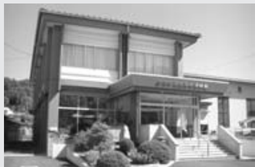
耐震改修が終了しリニューアルオープンした資料館
