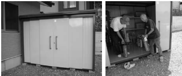
伊久間 防災倉庫
